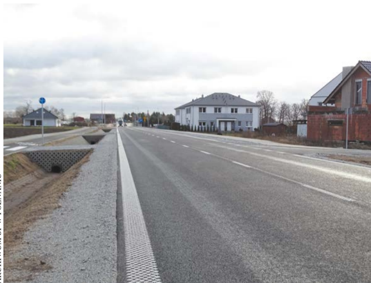
Droga powiatowa, która zmodernizowana została na odcinku prawie 7 km, przebiega przez teren trzech gmin
