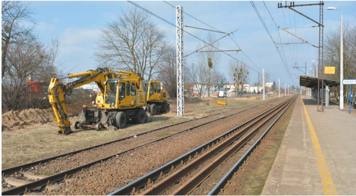
Początek prac modernizacyjnych na dworcu w Obornikach
