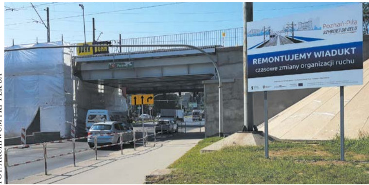
W ramach modernizacji linii Poznań Główny – Piła remontowany jest wiadukt na ul. Niestachowskiej w Poznaniu.
