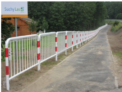
Fragment ścieżki rowerowej na odcinku Radojewo – Łysy Młyn na krótko przed oddaniem do użytku. Fot. UG Suchy Las
