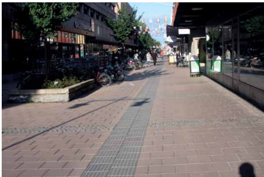
Ryc. 13. Pasy kierunkowe ułatwiające poruszanie się osób niewidomych powinny być wolne od przeszkód. Pasaż handlowy w miejscowości Gavle (Szwecja). (zdj. M. Wysocki)
