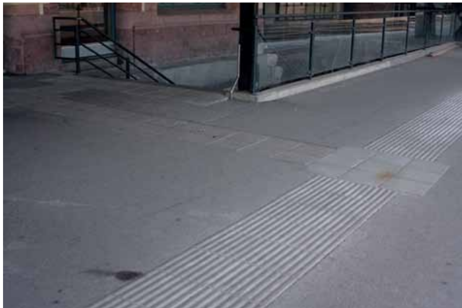
Ryc. 12. Informacja fakturowa w postaci pasów pozwala znaleźć osobie niepełnosprawnej wzrokowo bezpieczną Drogę. Peron dworca kolejowego w miejscowości Gavle (Szwecja). (zdj. M. Wysocki)
