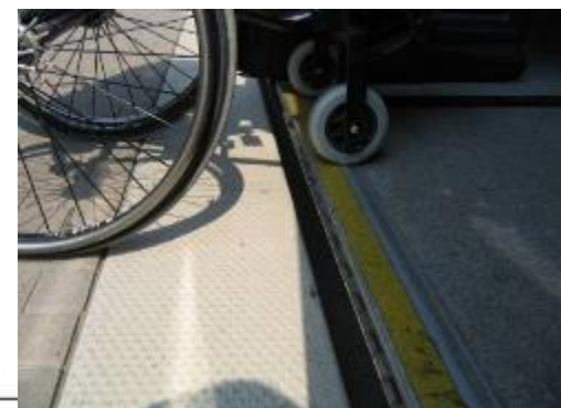
Ryc. 6.1 . Zakończenie krawędzi peronu przystanku betonowym profilem naprowadzającym (oprac. autora na podst. Majer, Suchanowski, 2010 [1]) .
