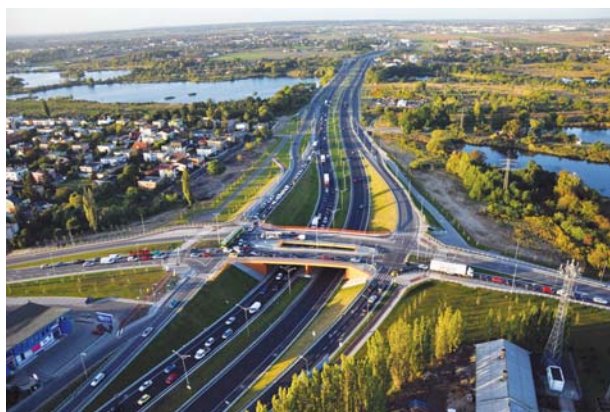
Przebudowana do rangi drogi ekspresowej ulica Głogowska.
